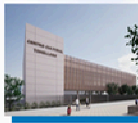
Centro Cultural en calle Tomelloso (en construcción)
