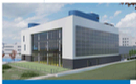
CDM Ricardo Damas (en construcción)
